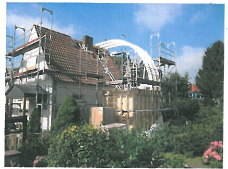
Bremen – Hemelingen, Dachsanierung eines Einfamilienhauses in Holzrahmenbauweise, Energieeinsparung: 58 %,
