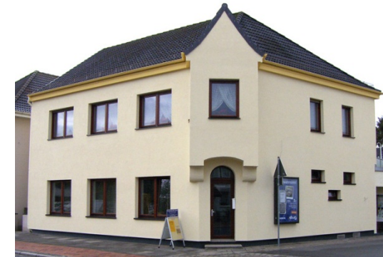
Bremen Mahndorf: Sanierung eines Wohn- und Geschäftshauses, Baujahr 1890, Energieeinsparung: ca. 60 %
