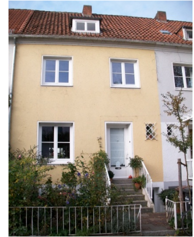
Bremen-Hastedt, Erkereinbau und Dachdämmung eines Einfamilienhauses, Baujahr 1936, Energieeinsparung: 58 %
