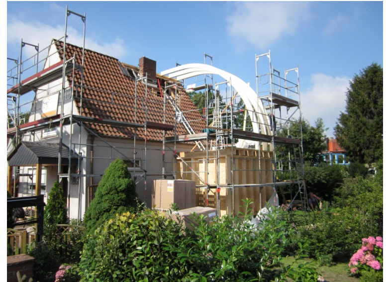
Bremen – Hemelingen, Dachsanierung eines Einfamilienhauses in Holzrahmenbauweise, Energieeinsparung: 40 %
