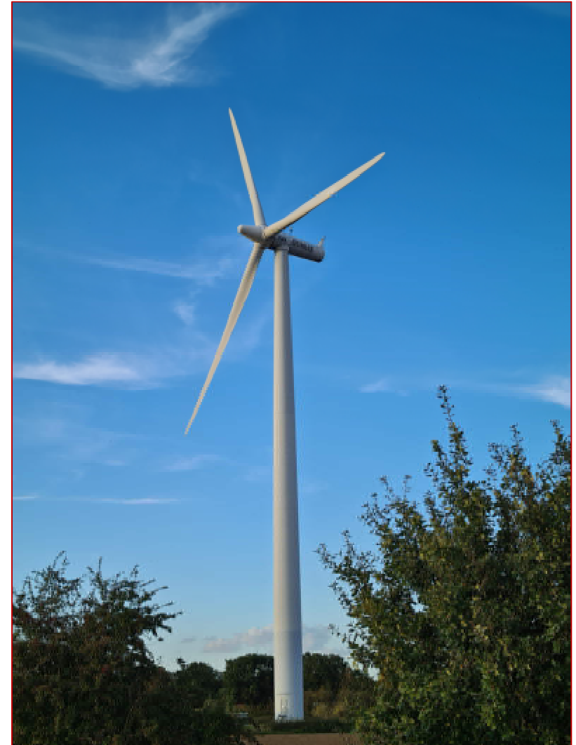
Windenergieanlage Mahndorf (eigenes Foto)
