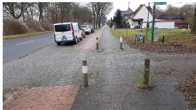
Foto 4: Ludwig-Roselius-Allee / Einmündung Champignonweg (südliche Nebenanlagen, Blickrichtung Osten)
