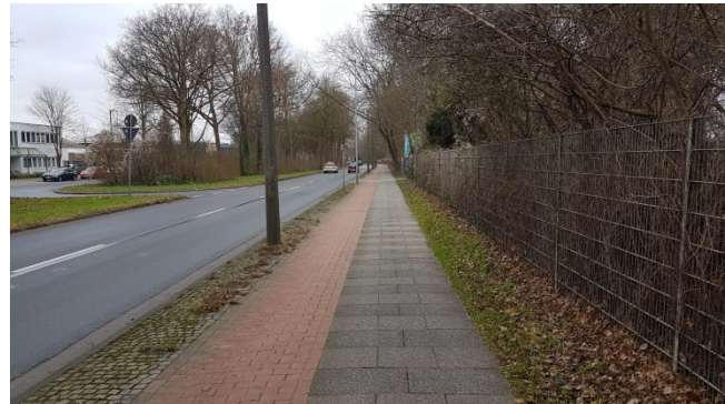
Foto 5: Ludwig-Roselius-Allee (nördliche Nebenanlagen, Blickrichtung Westen)
