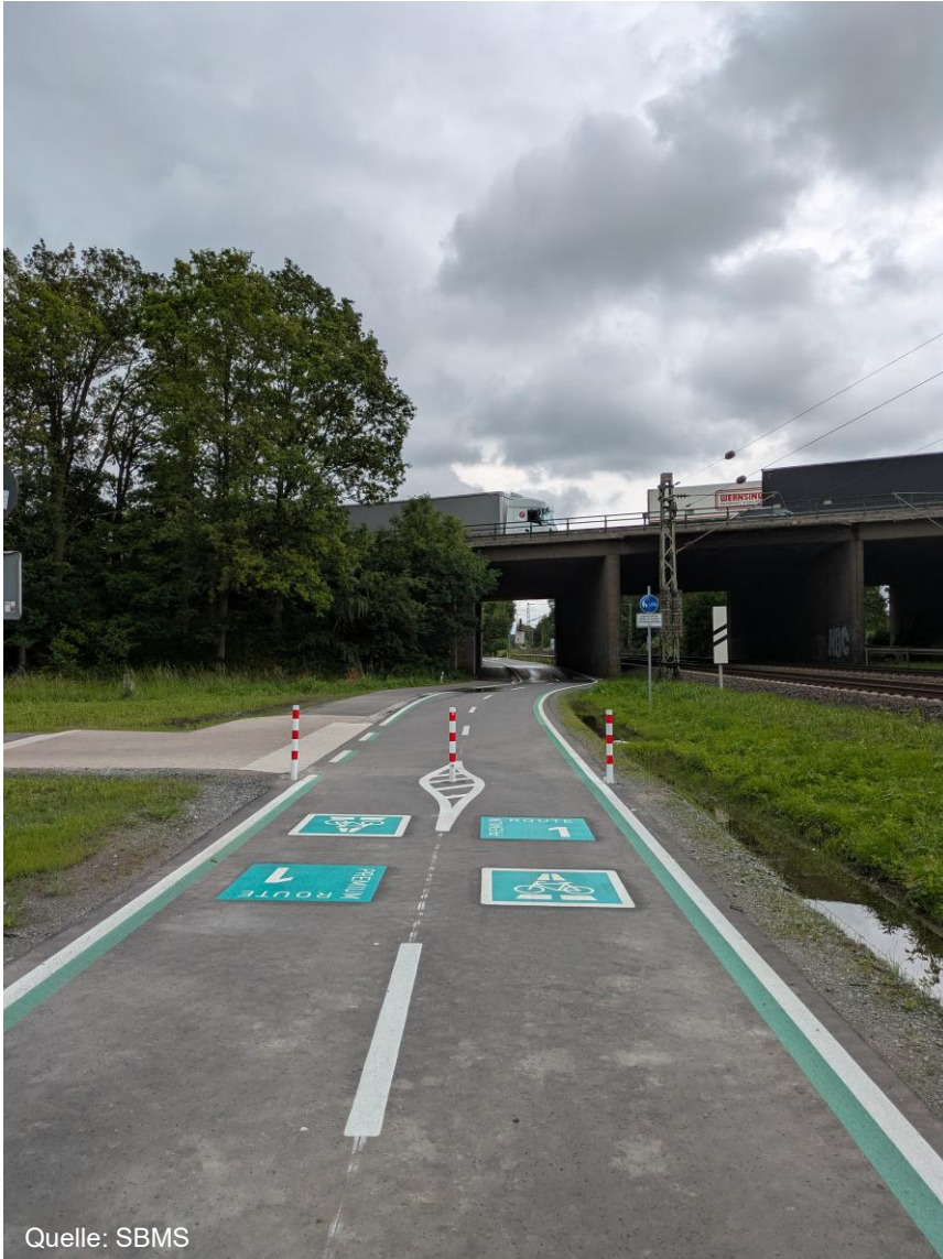
fertiggestellter Abschnitt der Premiumroute 1 in Achim
