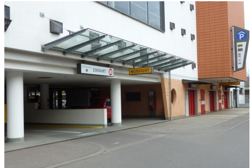
Quelle: SHP Ingenieure
