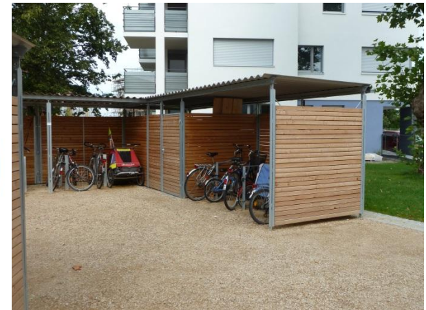
Quelle: SHP Ingenieure
