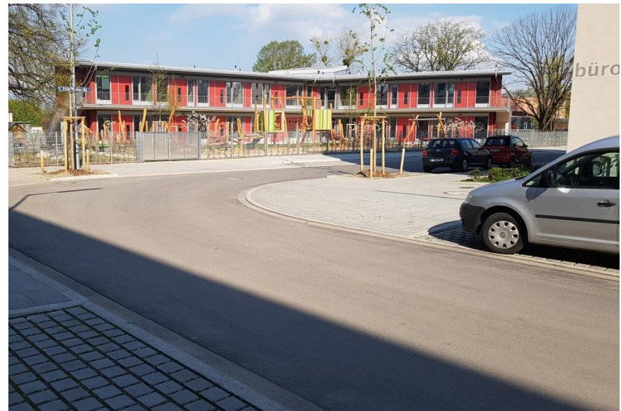
Quelle: SHP Ingenieure
