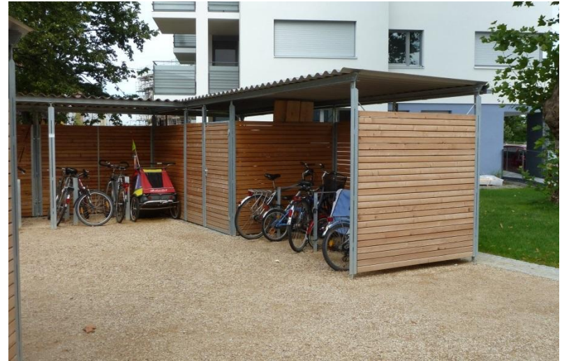
Quelle: SHP Ingenieure
