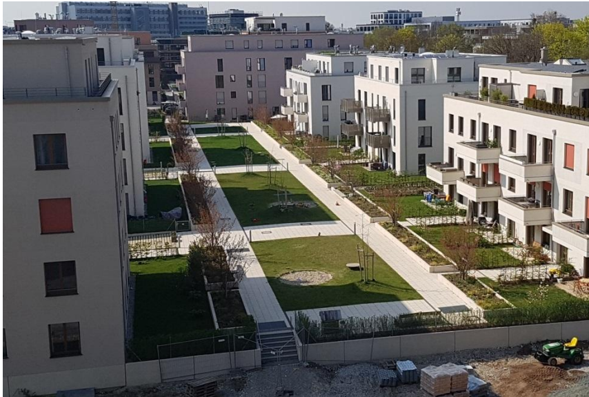
Quelle: SHP Ingenieure
